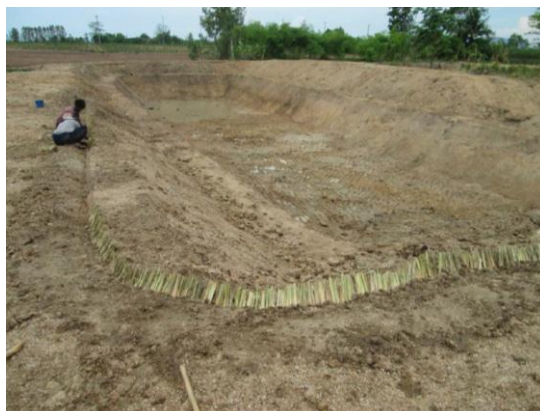
รูปที่ 5 การดำเนินการขุดสระ พร้อมปลูกหญ้าแฝกรอบบ่อน้ำ ในจังหวัดตาก ที่มา กรมพัฒนาที่ดิน, 2559.
