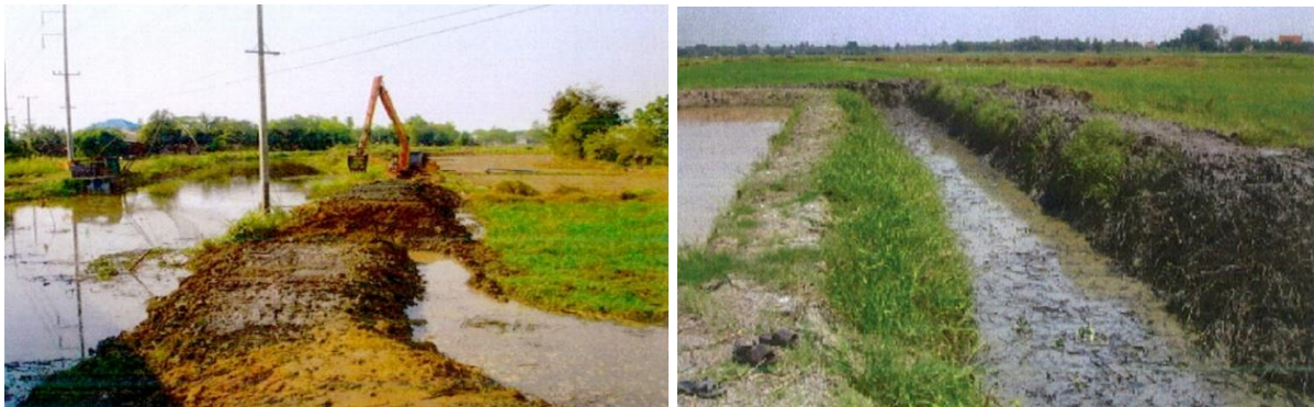
ภาพที่ 6 การขุดคลองข่อย ปรับปรุงยกระดับเสริมขยายคันดินกั้นน้ำ ที่มา : องค์การบริหารส่วนตำบลทับน้ำ, 2560ก.
