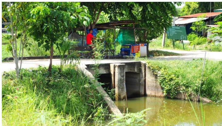
ภาพที่ 4: ท่อลอดเหลี่ยมคลองทับน้ำ ตั้งอยู่ใกล้วันฝั่งแดด
